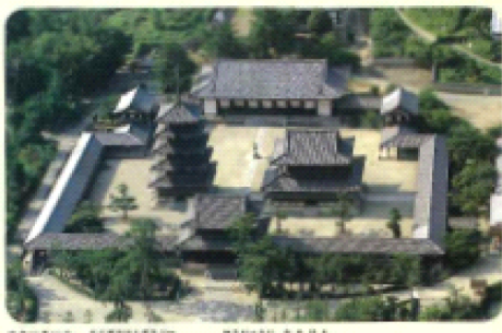
世界最古の木造建築物である法隆寺(奈良県)
